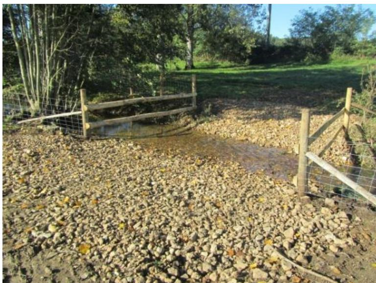
Figure 7 : Exemple de passage à gué rustique sur cours d'eau – Source : SMVT
